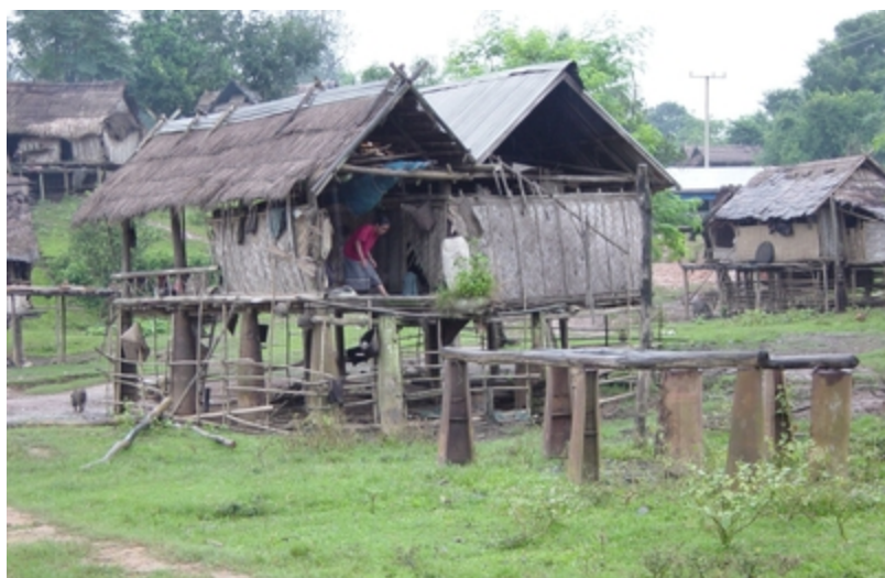
Das Dorf Khen Khun in der Provinz Savannakhet am früheren Ho-Chi-Minh-Pfad, der besonders stark mit Streubomben verseucht wurde. Die Dorfbewohner benutzen die Bombenhüllen für die Pfahlkonstruktion ihrer Hütten. © K. Baetens/ Handicap International
